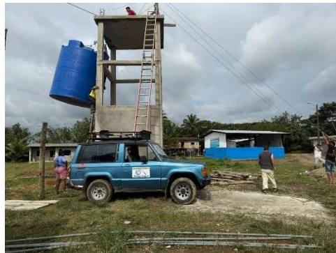
Turm der Wasserversorgung La Cadena
